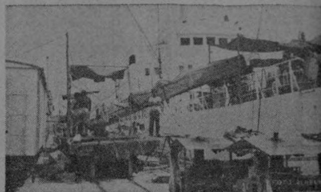
Cuando se instalen los sistemas modernos de carga y descarga, el puerto de Limón obtendrá un movimiento inimaginado.
