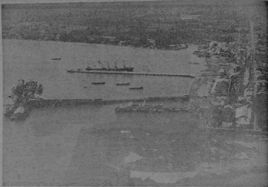
Una vista completa de los muelles de Limón, en plena operación.
